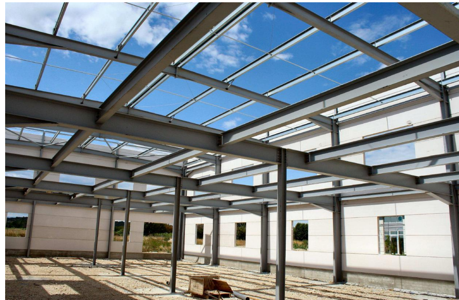
Sistema estructural STRUGAL S52 CRi
